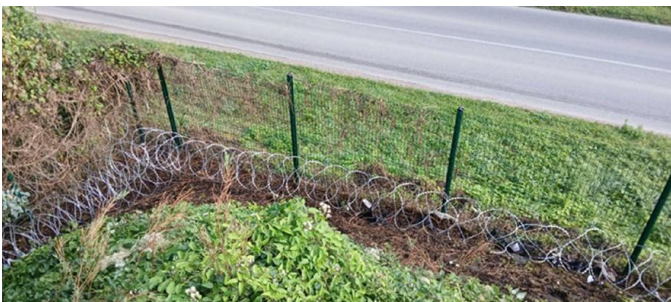
Clôture en phase de réparation à Malesherbes
